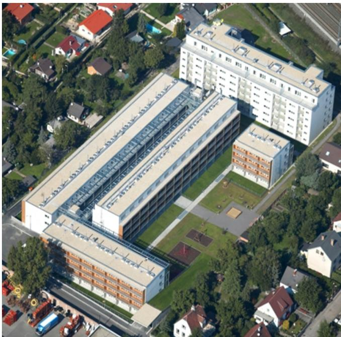
Das Projekt Spöttlgasse in Wien XXI wurde nach der Novellierung der Wiener Bauordnung, Ausgabe Jänner 2001, die Holzwohnbauten bis zu einer Höhe von 4 Holzgeschossen auf einem in Massivbauweise errichteten Sockelgeschoss zulässt, konzipiert.
