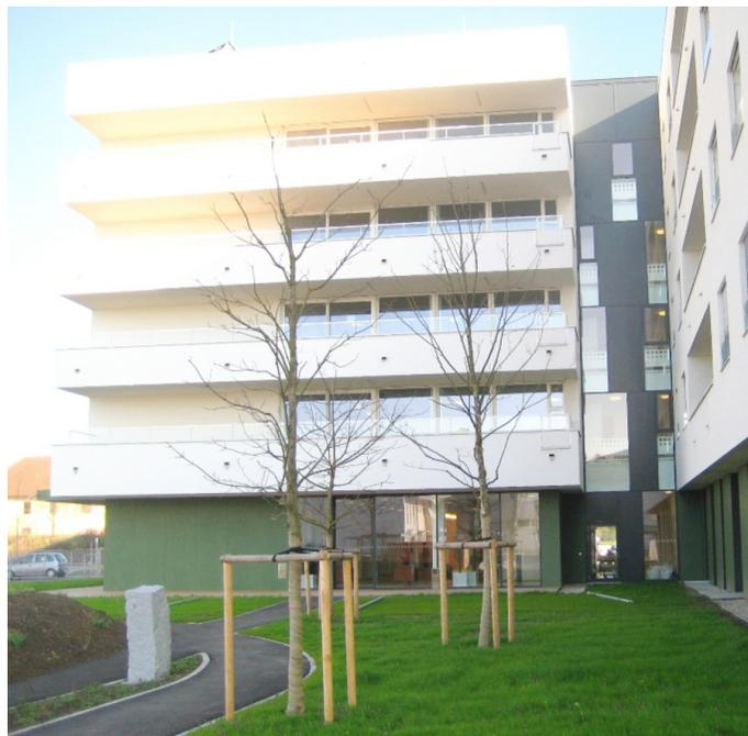
**Erstes Alten- und Pflegeheim Österreichs in Passivhausbauweise:** Das Bauwerk wurde im Passivhausstandard mit einer Energiekennzahl von 7,4 kWh pro Jahr und Quadratmeter ausgeführt. Das gesamte Objekt ist kontrolliert be- und entlüftet
